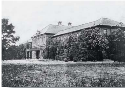
明治23年5月に新築された当時の校舎。奏楽堂は建物の2階中央部分に位置し、その両側に校長室、女教員室、教室、練習室などがあった。1階は事務室、男教員室、教室、練習室、食堂、小使室など。生徒が校舎に出入りする際は、正門から玄関に向かって建物の左端に「男生徒昇降口」、右端に「女生徒昇降口」が別々にあった。
