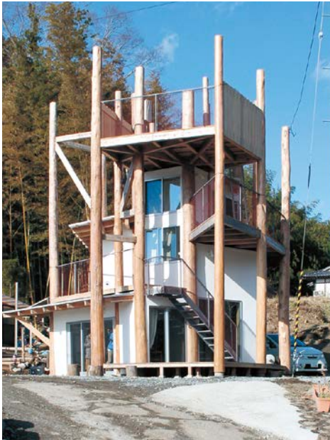
陸前高田「みんなの家」外観 撮影：乾久美子建築設計事務所
