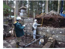
日光輪王寺慈眼堂廟塔の復旧工事（財団法人日光社寺文化財保存会提供）
