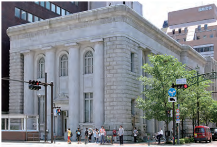
① 馬車道校舎 Bashamichi Building
