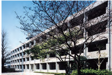
音楽学部3号館 Building III, Faculty of Music
