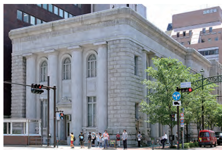
① 馬車道校舎 Bashamichi Building
