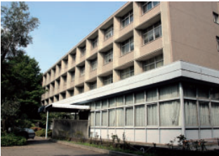
音楽学部 5 号館 Building V , Faculty of Music
