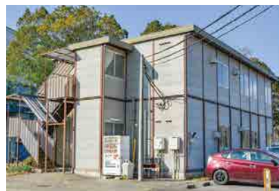
④ プレファブ (染め・紙漉き工房) 自然素材を対象とした染色・紙漉き制作の場。大規模駐車場と共に、キャンパス中央部に設置されている。
