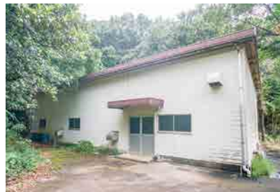
② 排水処理施設 用途：排水設備 竣工年：1990年
