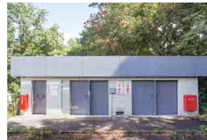
③ ガス供給施設 用途：ガス設備 竣工年：1991年
