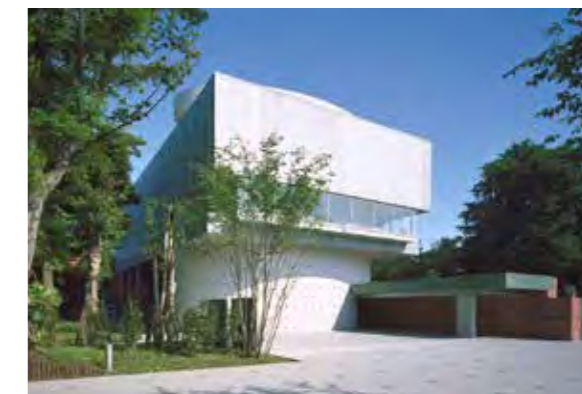
② 大学美術館本館 用途：エントランスホール、展示室、ギャラリー、収蔵庫、食堂(ホテルオークラ、藝大食楽部)、ショップ(画翠)、売店、教員研究室、図書室、X線撮影室、館長室、事務室、会議室、応接室、未来創造継承センター 竣工年：1999年
