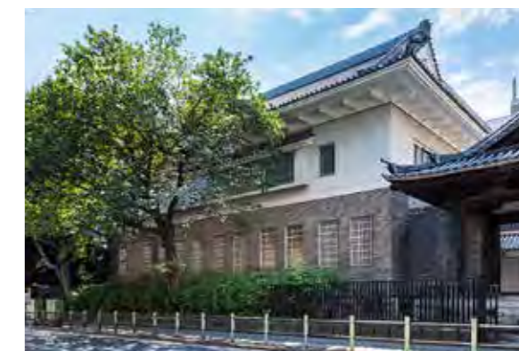
④ 正木記念館 用途：未来創造継承センター、和室 竣工年：1935年 東京都選定歴史的建造物：2009年
