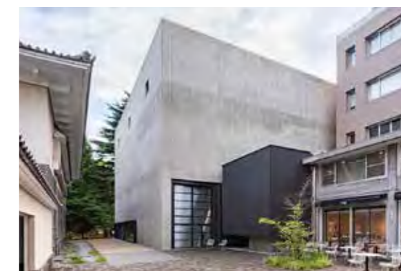
⑥ 国際芸術リソースセンターB棟(IRCA)／附属図書館 用途：図書館(開架・閉架書庫)、ラーニングコモンズ 竣工年：2017年
