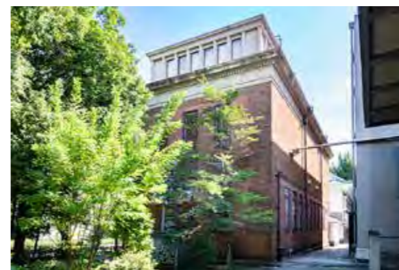
③ 陳列館 用途：陳列室(ギャラリー)、倉庫 竣工年：1929年 東京都選定歴史的建造物：2009年
