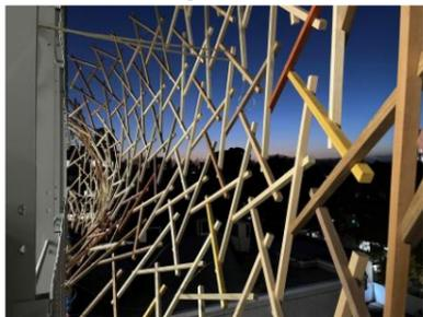
形態を構造解析して得た応力の違いを樹種の違いで解決し、木組による架構を制作します。互いが互いを支え合う構造形式を用いて、強度の異なる木材が全体をかたちづくれます。すべての木材がシルバーグレー色に風化しても残る、木材の構造的特性を通して、素材の表層と深層を同時に扱うことを考えました。かたちが、ただかたちとして存在すること。素材が、素材らしくあること。「そのそれらしさ」について考えます。
