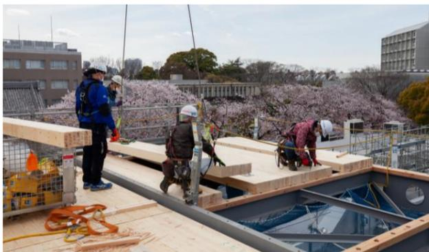
Nail laminated Timber (NLT) は並べた製材同士を釘やビス等によって固定し床板を構成する工法です。鉄骨部の床をNLTとすることで、建物重量の軽量化・工期短縮を実現しています。国内の大規模案件の床では初の採用事例となります。新しい木材の使い方として今後も使用が見込まれます。
